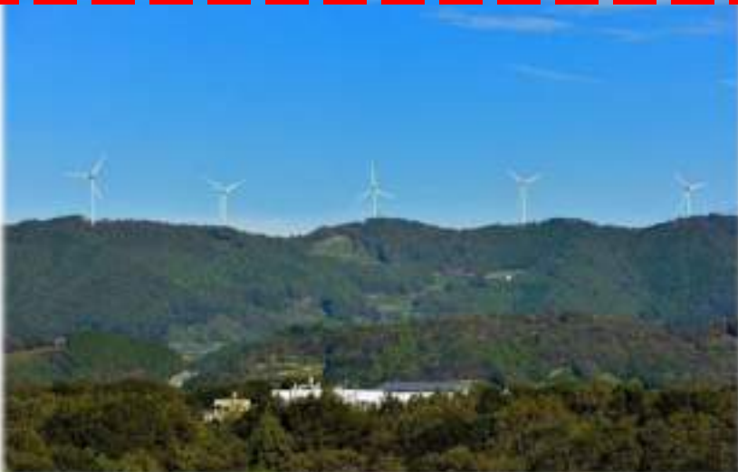
浜松風力発電所
